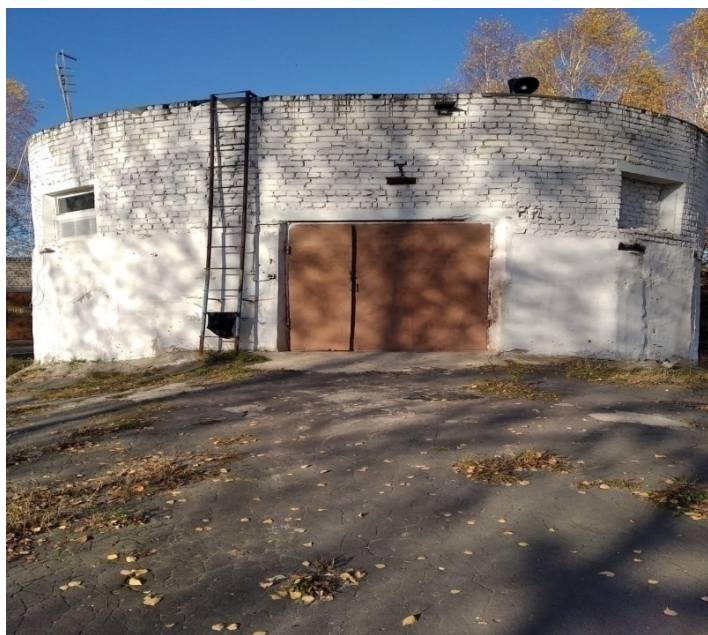
Канализационная насосная станция КНС -2
